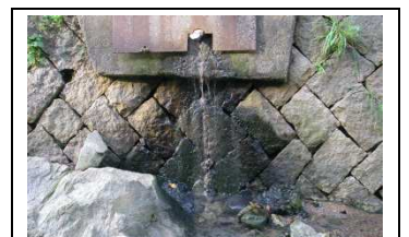
生活排水の流入部
